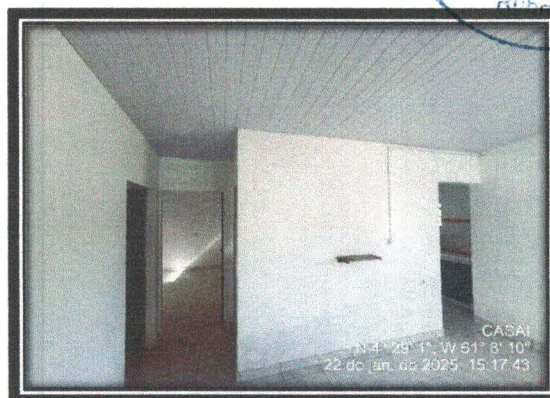
Foto 02 – Vista interna da Edificação
