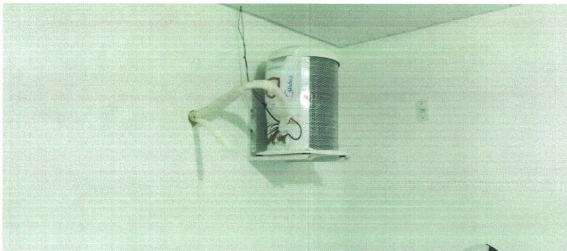
Foto da instalação de uma dentro sala.
